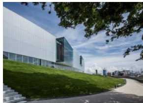
外壁(アルミ特注パネル使用)
